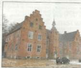
Nach vier Jahren ist die Sanierung von Schloss Hagen in Probsteierhagen jetzt abgeschlossen. Rund 3,5 Millionen Euro wurden investiert, um das Gebäude wieder instand zu setzen.
