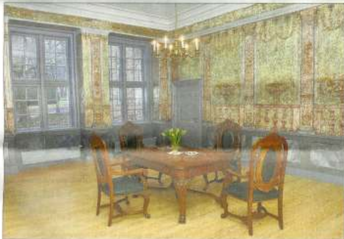
Bei den Sanierungsarbeiten wurde die Stucco-Lustro-Malerei im Pogwisch-Zimmer entdeckt und wieder freigelegt. Die an Marmorflächen erinnernden Arrastrien lassen den Raum als eine große Terrasse erschreiben. Entstanden sind sie Anfang des 18. Jahrhunderts. Foto sen
