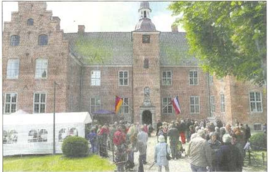
Am Sonntag wurde Schloss Hagen nach vierjähriger Sanierung feierlich eingeweiht. Über 200 Gäste wohnten der Eröffnung bei.
